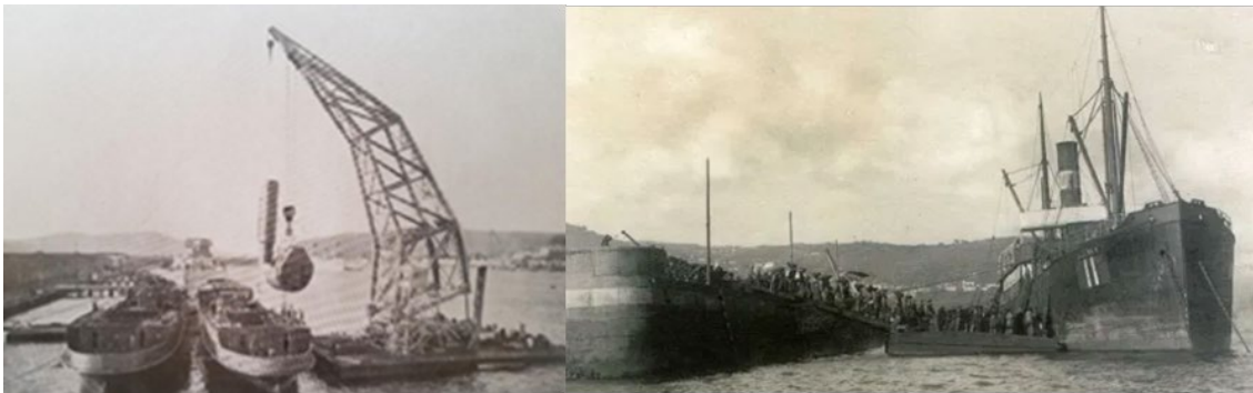
Figura 5. Pontona y primeras grúas en el puerto de Ferrol.
