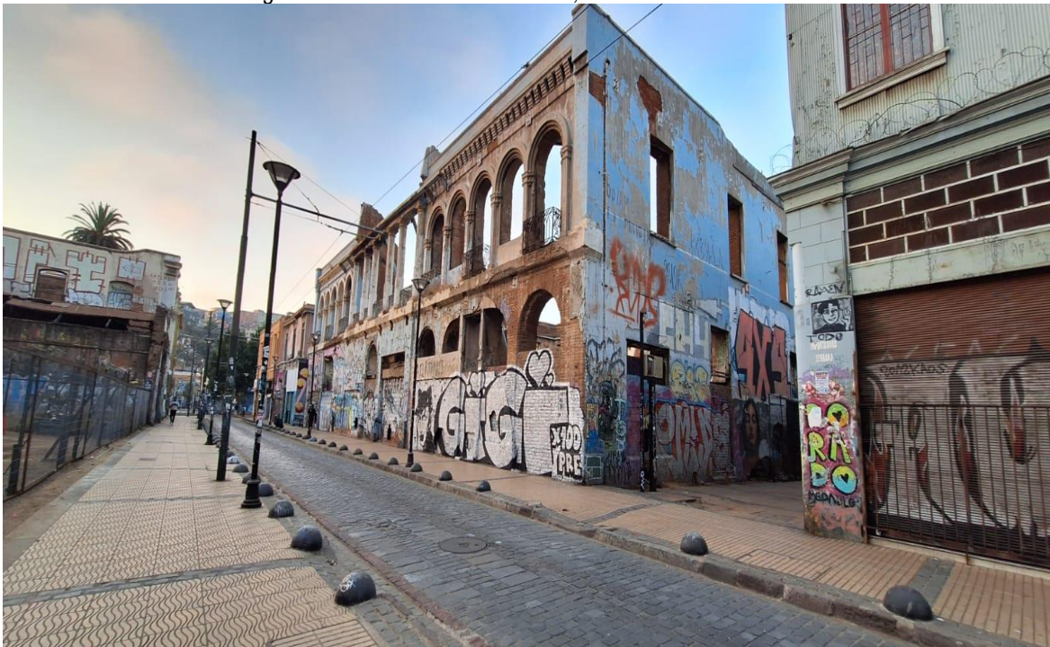
Figura 3. Inmuebles abandonados, Barrio Puerto
