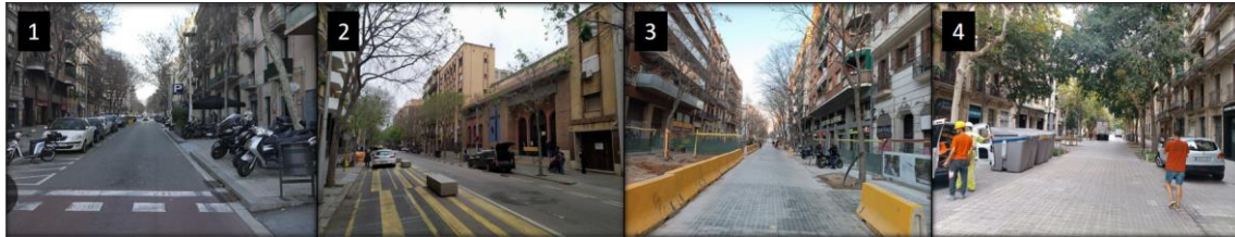
Figura 2. Paisaje de la calle Consell de Cent en distintos momentos: (1) con la distribución tradicional de los usos (2019), (2) en la etapa de urbanismo táctico (2021), (3) durante las obras de los ejes verdes (febrero 2023) y (4) con la reforma terminada (setiembre 2023).
