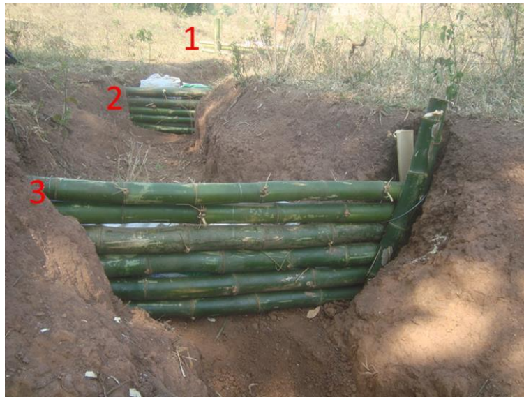
Figura 292 Disposição das paliçadas de bambu na ravina | Fonte: fonte própria.
