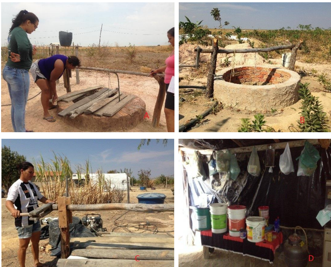
Figura 169 A, B, C e D: Estruturas de captação de água subterrânea e armazenamento de água | Fonte: acervo da autora.
