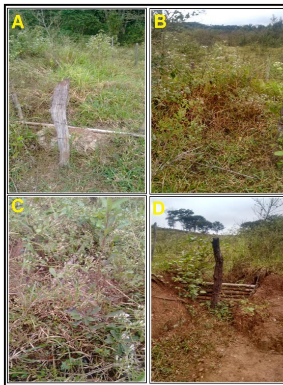
Figura 299 Acompanhamento da recuperação da ravina no dia 14/06/2018 | Fonte: fonte própria.
